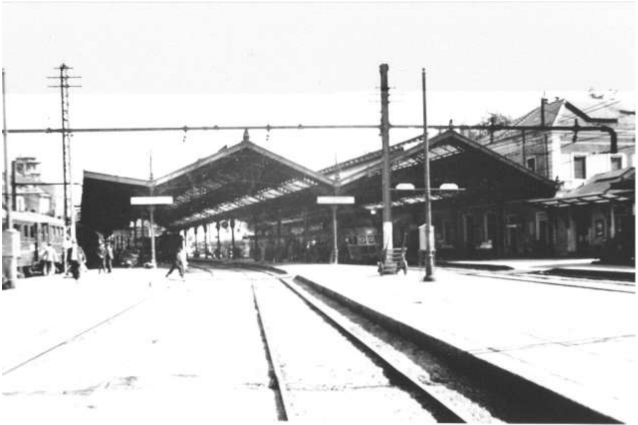
La gare de Chambéry sous caténaies 1500 volts. Collection G. JENNY
