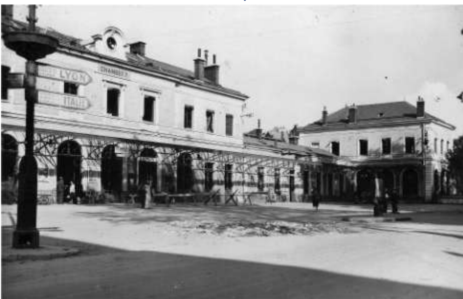
Le bâtiment voyageur a été soufflé, il est hors d'usage.
