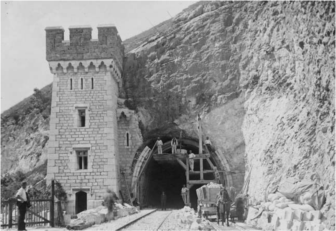
Tunnel de Brison : travaux de pose de la seconde voie. La voute des 3 tunnels situés le long du lac du Bourget doit être retaillée pour dégager le gabarit de la seconde voie. Collection F. POUS
