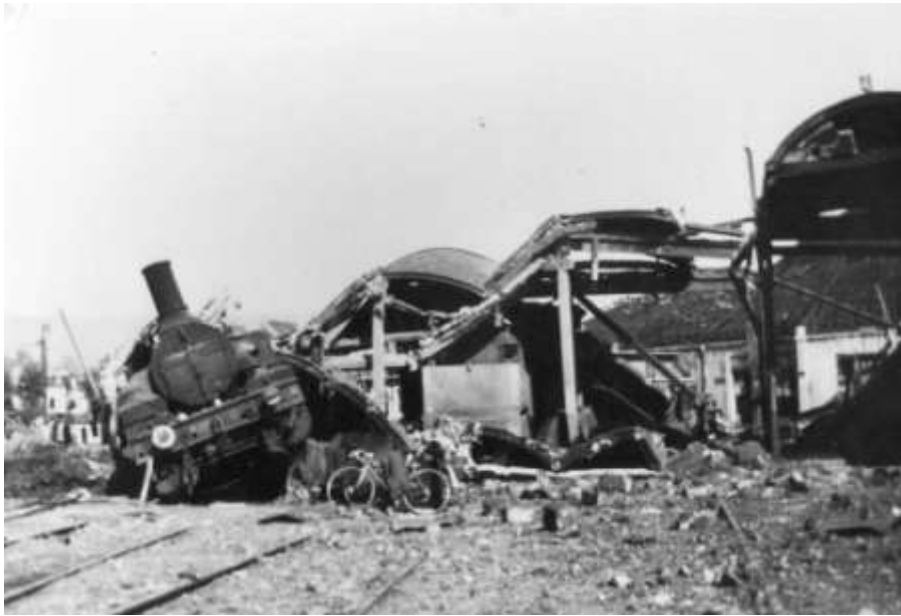
La remise annulaire s'est effondrée sur les locomotives.
