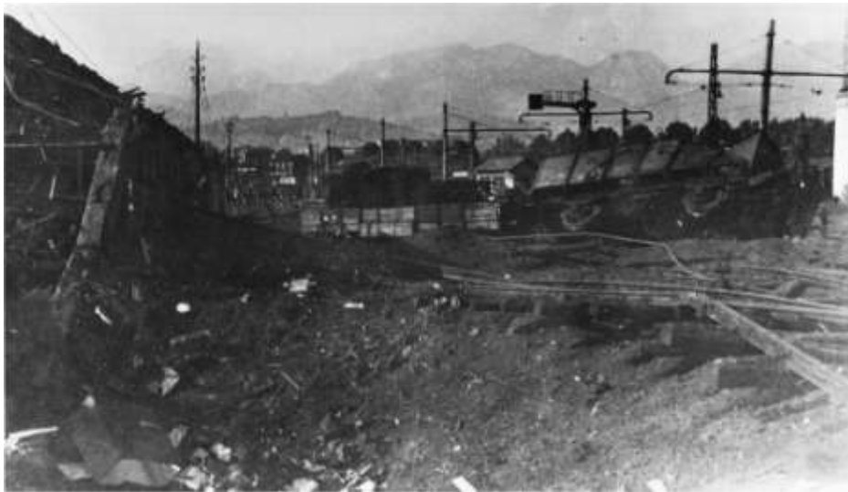
Les restes du chantier de réparation des wagons.
