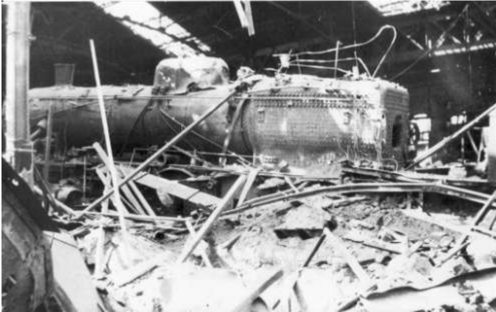
L'atelier vapeur est détruit.
