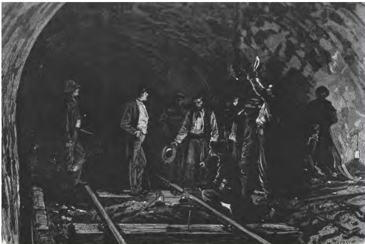
La pose du dernier rail sur la première voie.
