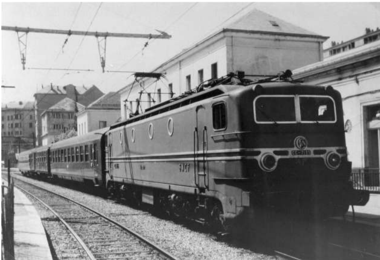
CLa CC 7135 Maurienne entre en gare de Chambéry lors des travaux de 1972.
