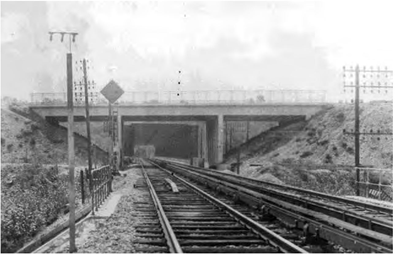
La ligne avec son rail latéral de contact au pont Royal entre Saint Pierre d'Albigny et Chamousset. Collection G. JENNY
