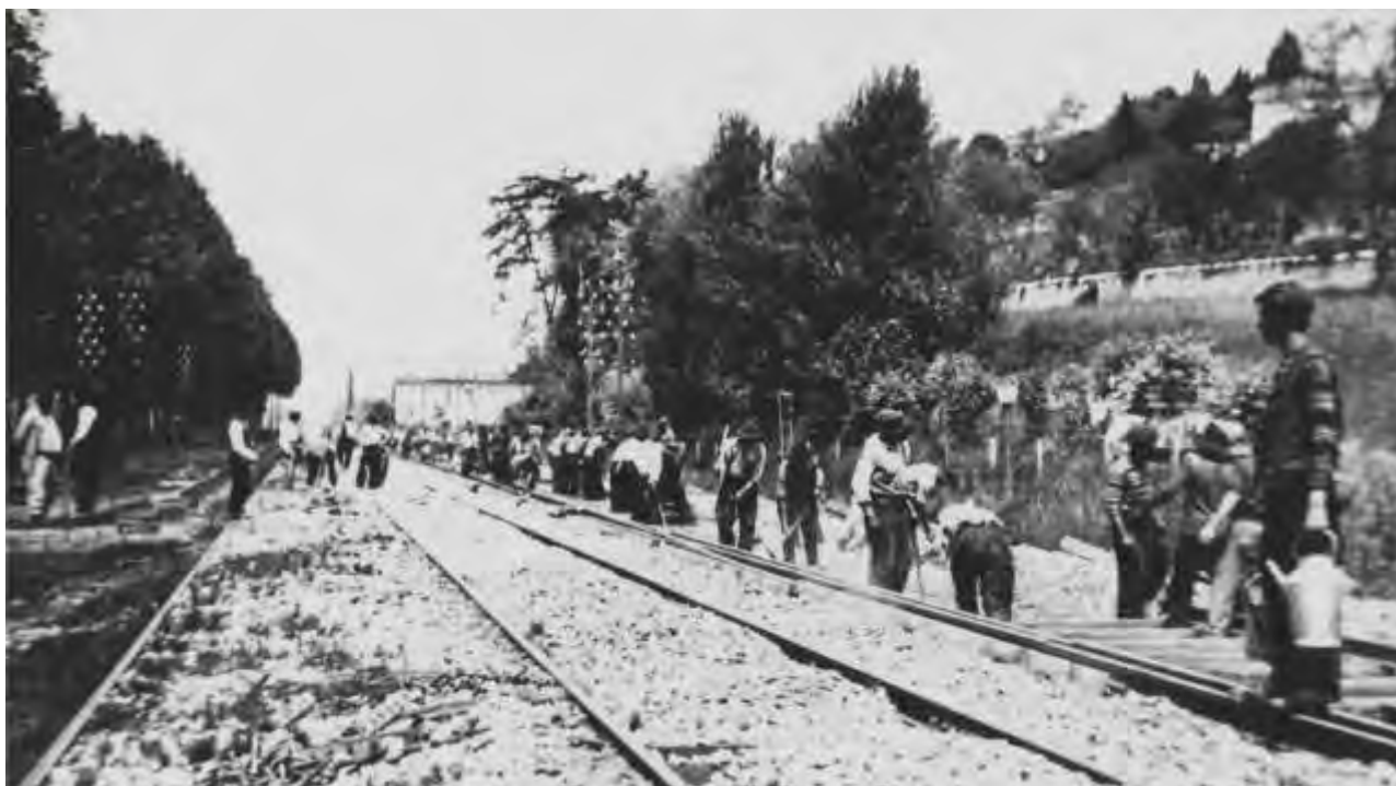
Travaux de pose de la seconde voie à la sortie de la gare, le long de l'avenue de la Boisse. Cliché Musée Savoisien, collection G. JENNY
