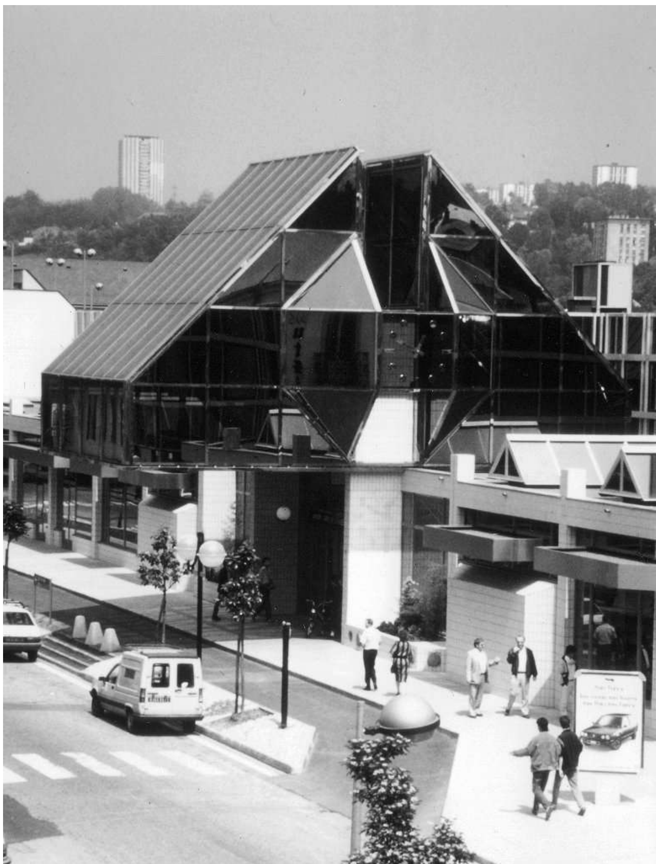
La nouvelle gare de Chambéry en 1988.
