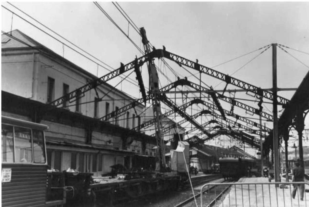
Démontage de la grande halle métallique de la gare.
