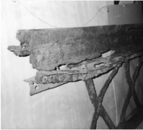
A gauche, l'état de corrosion d'une panne du châssis vitré circulaire, à droite, l'action de la corrosion sur le pied d'un lanterneau. Clichés et collection G. JENNY
