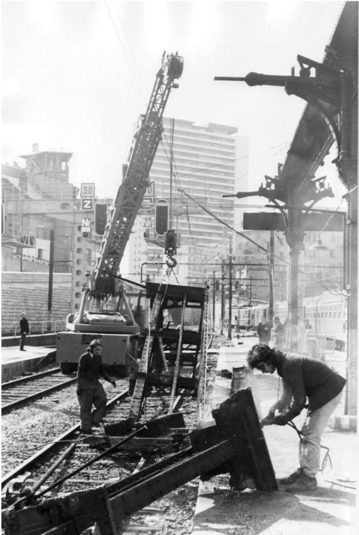
Découpage d'un pilier de la grande halle.
