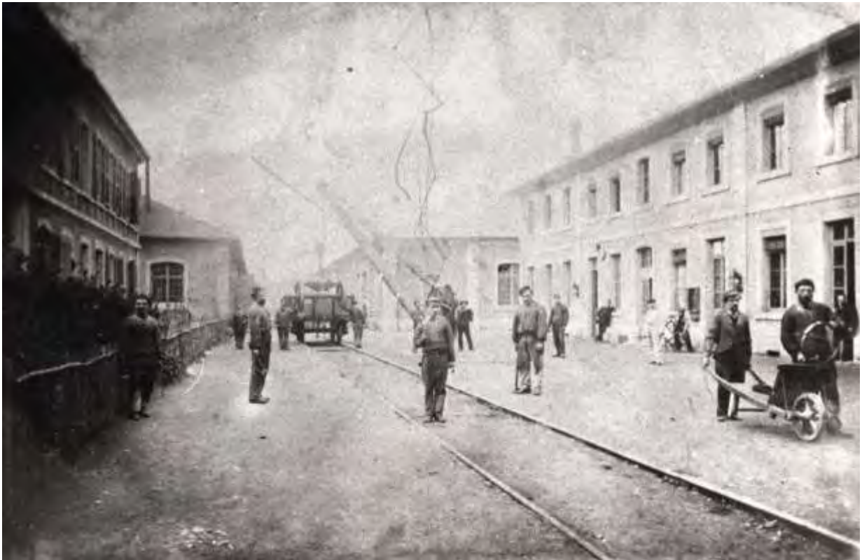
La seule photographie connue du dépôt en 1865, vue prise en direction d'Aix. Au premier plan, à gauche, les logements des Chefs et Sous Chefs de dépôt. En face, celui des bureaux de la compagnie. A l'arrière, à gauche, l'atelier de levage. En face, le bâtiment qui abrite la machine alimentaire, l'atelier de fabrication des pièces et les dortoirs des mécaniciens et chauffeurs. Cliché Musée Savoisien, collection G. JENNY.
