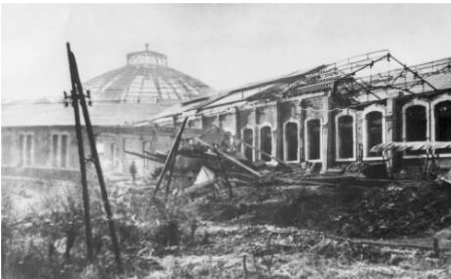
Les restes de l'atelier vapeur et des bureaux.
