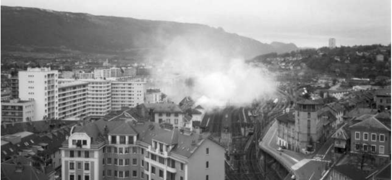
La toiture de la gare de Chambéry en feu. Cliché Alice BERLIOZ, collection G. JENNY
